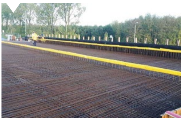
Oplossing Alle stekeinden ruim 600m door de vlechters afgedekt.
