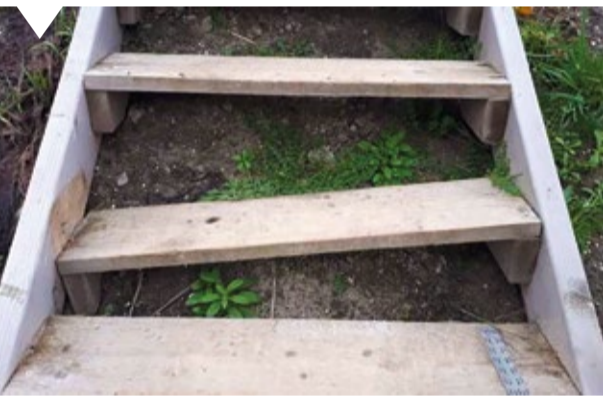
Risico Traptrede zit aan een kant los van taludtrap. Gevaar Valgevaar.
