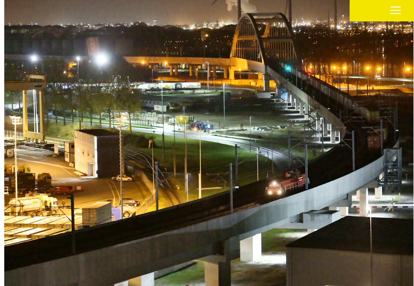
Havenspoorlijn Theemwegtracé, Rotterdam-Botlek
