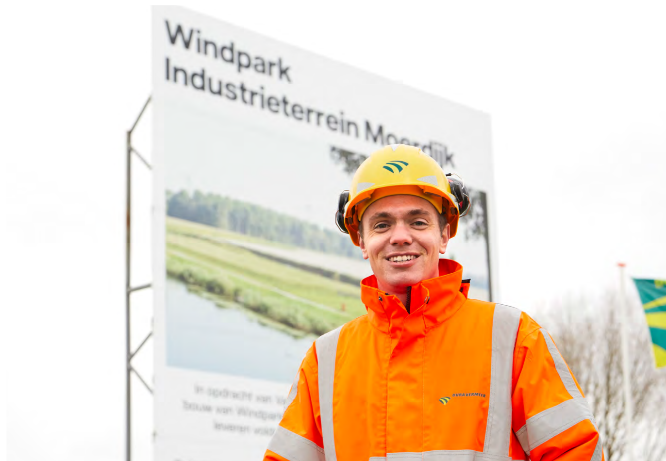
Realisatie fundering windpark Moerdijk
